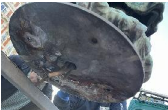
Afbeelding 3: Onderaanzicht: bevestigingsgaten © Gemeente Sint-Gillis
