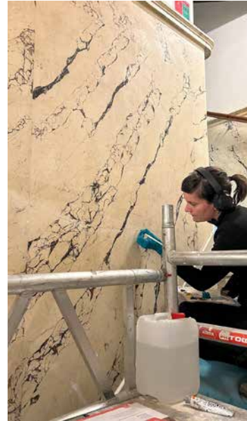
↑ Rénovation de la Maison Pelgrims
