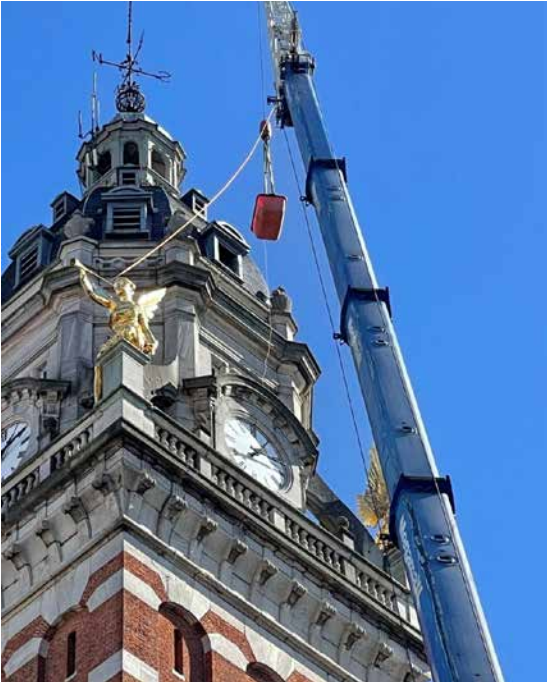
↑ Renforcement de la structure du beffroi de l'hôtel de ville
