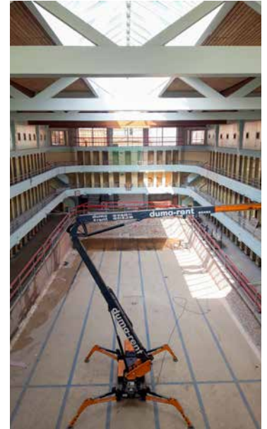
↑ Rénovation de la piscine communale Victor Boin
